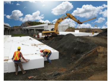
Remblaiement de routes/ stabilisation du sol
