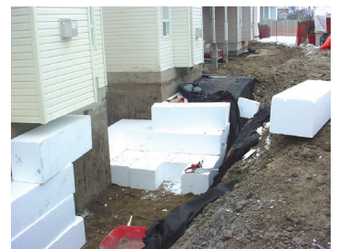
Matériau compressible appliqué contre des structures
